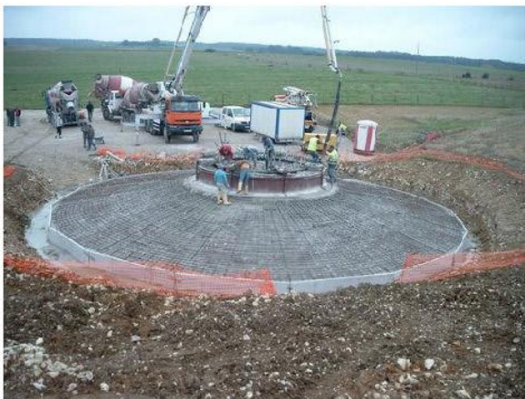
Schéma d'une fondation d'éolienne
