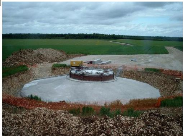
Photographies de fondation d'éolienne avant et après le coulage du béton
